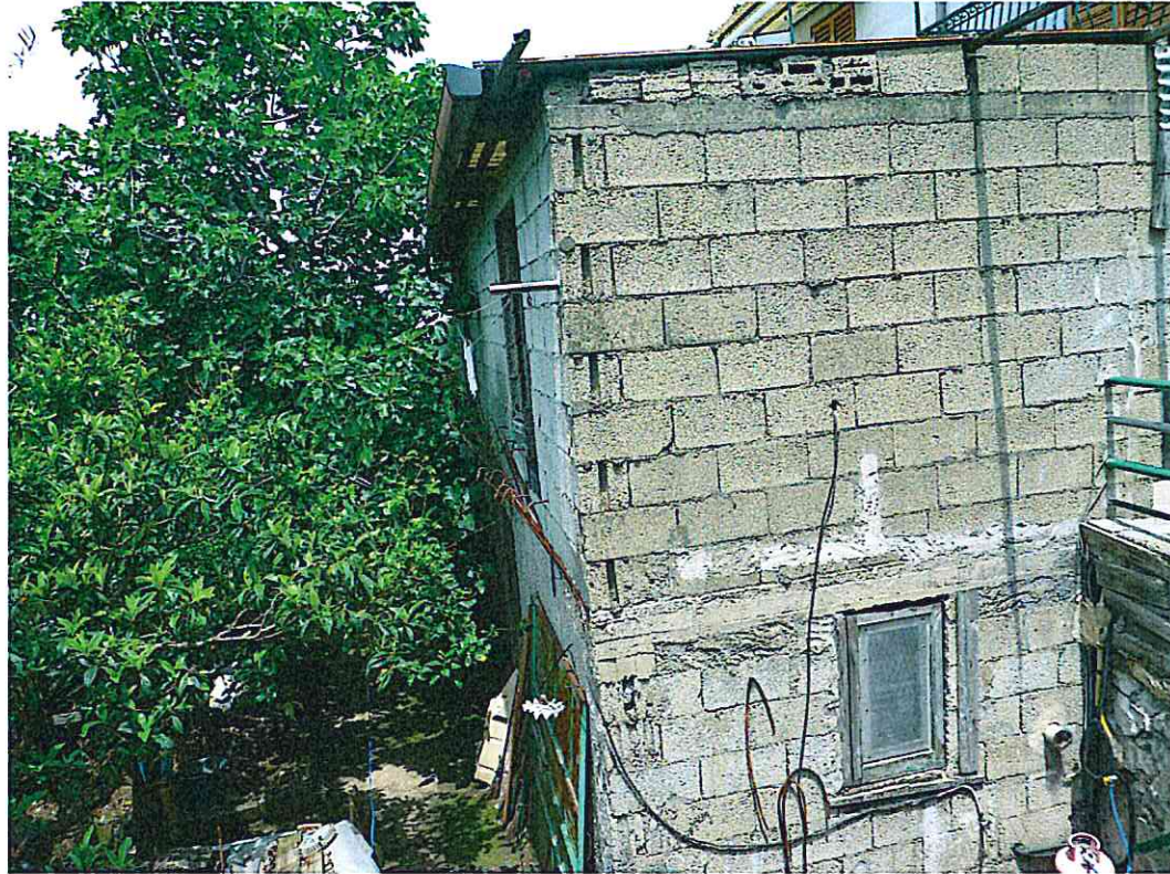
Foto G (manufatto garage e deposito seminterrato)
