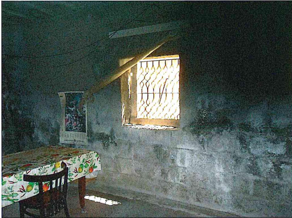
Foto interni piano terra
