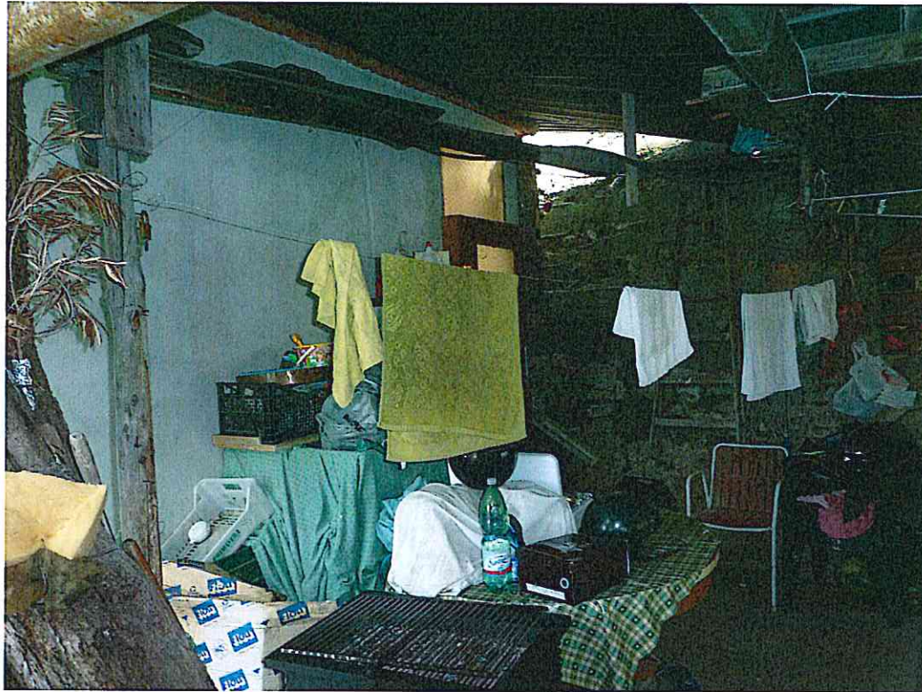
Foto O (tettoia-rimessa)
