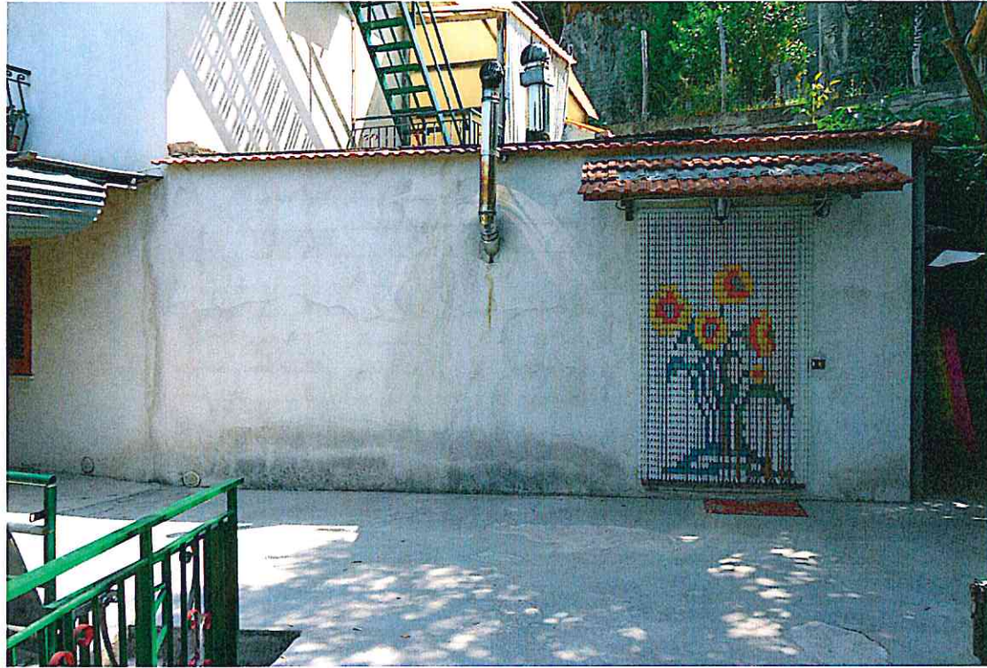
Foto E (manufatto trapezoidale adiacente)
